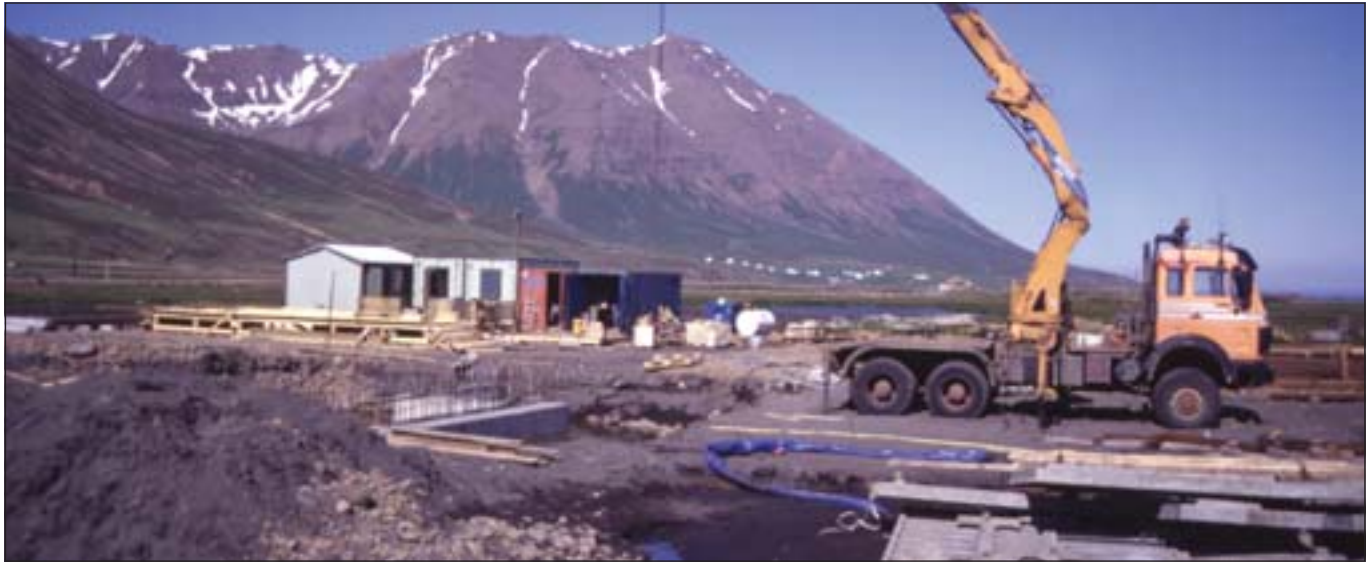
Nú er hafin vinna við gerð brúar yfir Ólafsfjarðarós. Hún er 40 m löng í tveimur höfum. Það er Mikael ehf. á Hornafirði sem byggir brúna. Þetta er fyrsti áfanginn af nýjum vegi að gangamunna Héðinsfjarðarganga í Ólafsfirði.
