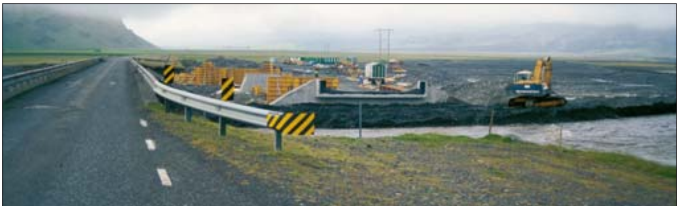
Nú er verið að byggja nýja brú á Klifanda á Hringvegi í Vestur-Skaftafellssýslu. Brúin er 64 m löng og kemur í stað einbreiðrar brúar sem er orðin léleg. Það er brúarvinnuflokkur Vegagerðarinnar frá Vík í Mýrdal sem byggir brúna. Í baksýn sést Pétursey.
